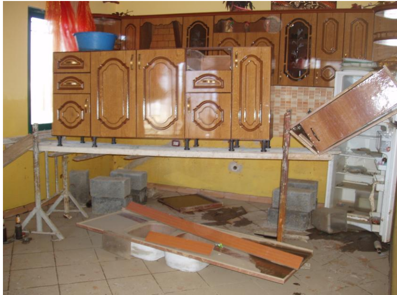
Der Küchenschrank ist auf dem Gerüst gesichert
